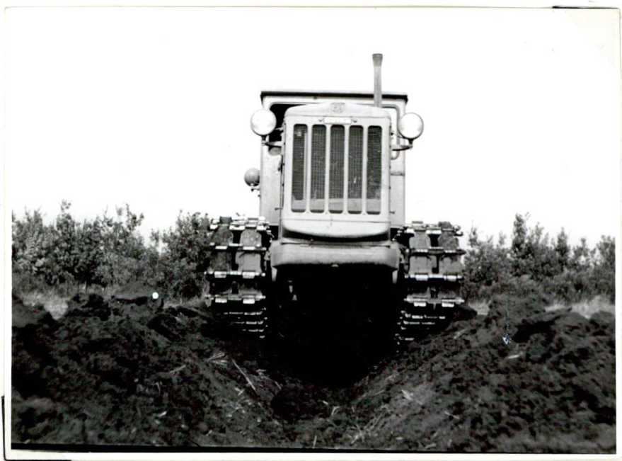
16. kép. Ideiglenes csatorna kihuzása /Nagyhörcsög/
