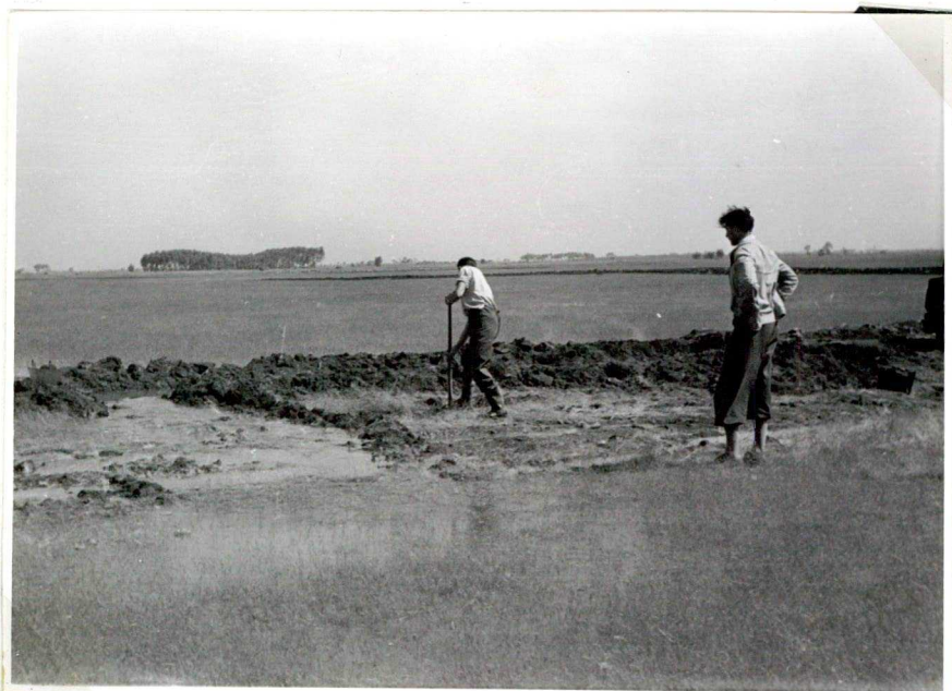
31. kép. Legelő öntözése ideiglenes csatornával
