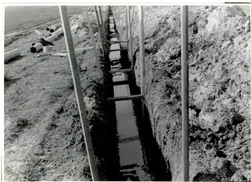
5. kép. Talajviz akadályozza a telep építését
