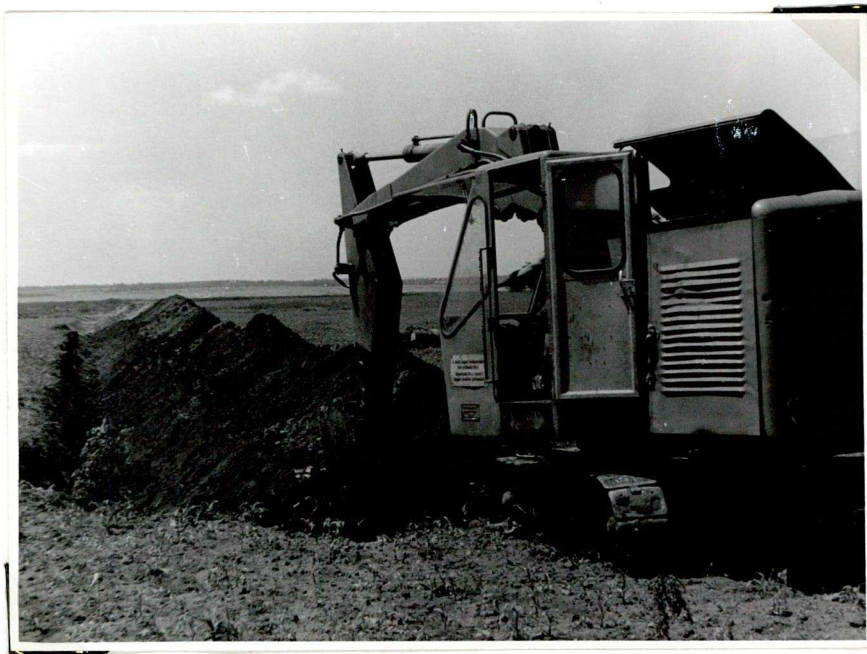
8/a. kép. Öntözőtelep építése
