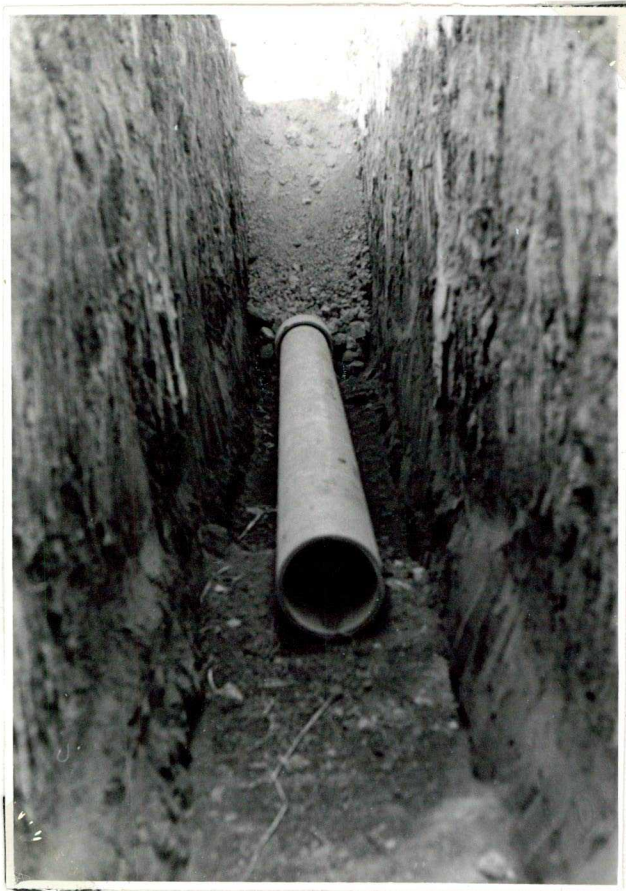
6. kép. Ilyen mélyre kerülnek a csövek
