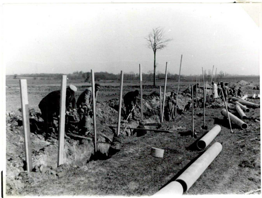
4. kép. Azbeszt-cement nyomócsöves öntözőtelep építése. /Sárszentmihály/
