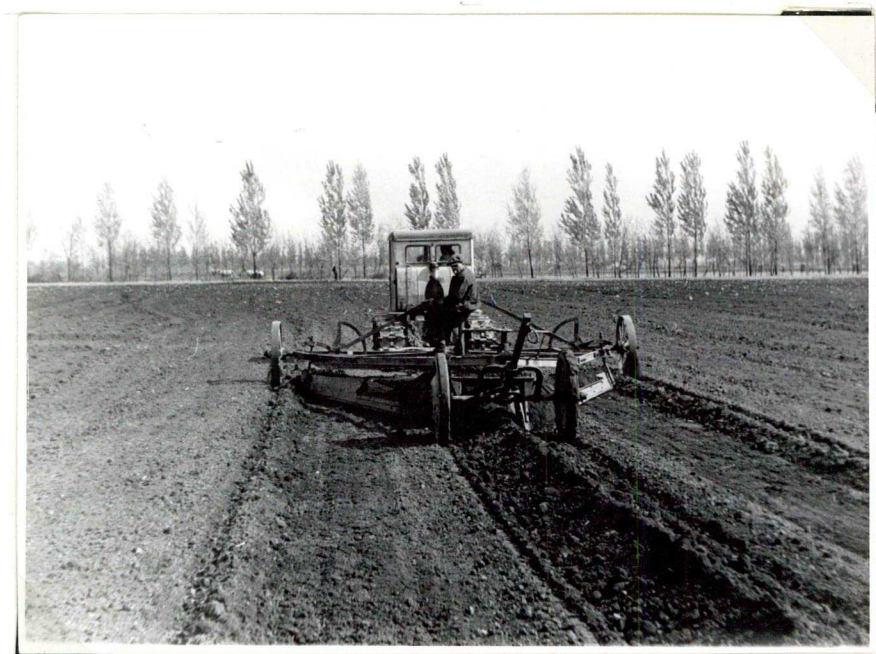
41. kép. Sávcsörgedeztető csatorna kihuzása
