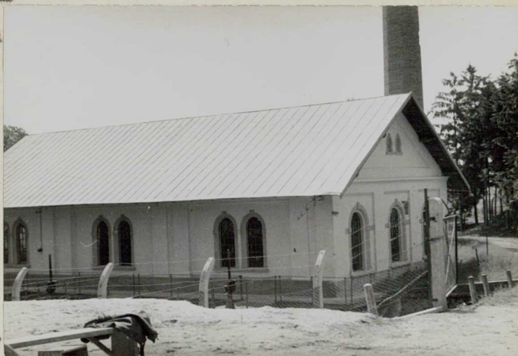
7.kép: Szivattyutelep Érsekcsanádön.
