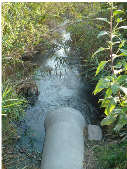
2.2. kép: Földmedrű csatorna Cserkeszőlő határában
