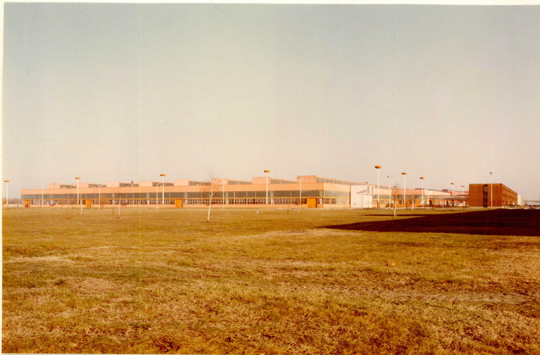
A RÁBA új, 67000 m 2 -es megmunkáló csarnoka és technológiai előkészítő épülete
