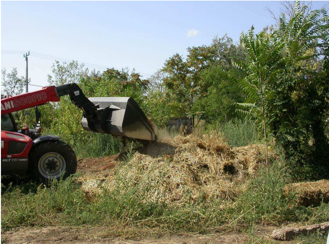
3. kép: A szennyezett talaj szalmával történő bekeverése
