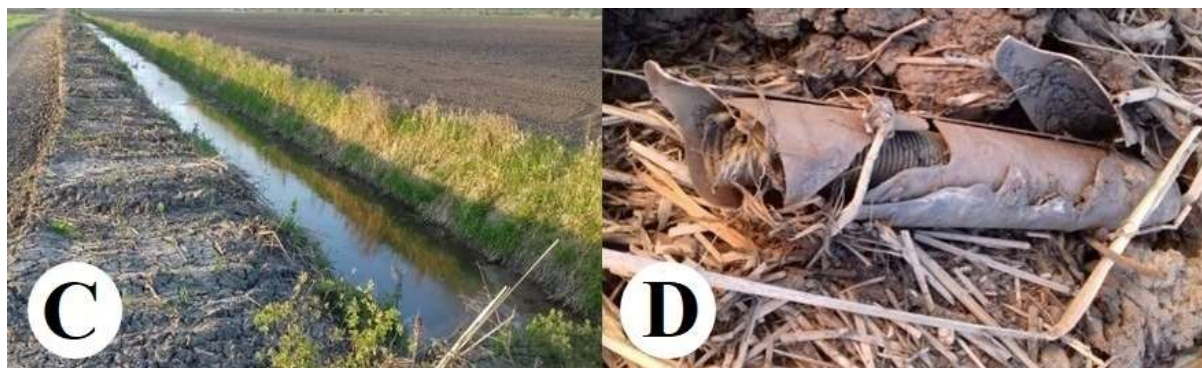
53. ábra. A drének jellemző sérülései: (C) földmedrű csatorna iszapkotrás után a csanyteleki területen és (D) kiszakított dréncső kifolyó és perforált dréncső a csanyteleki csatorna menti iszapmeddőben (TÚRI ÉS TÁRSAI 2021)
