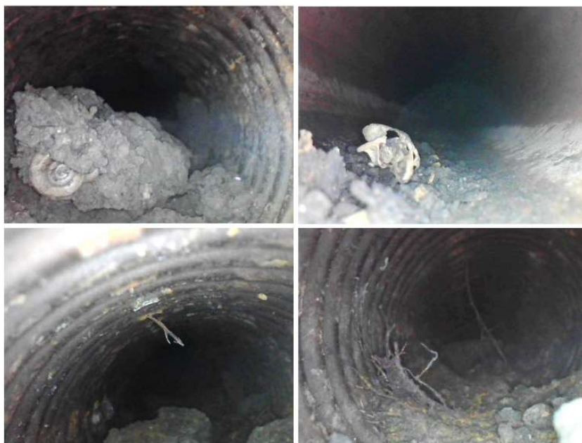
51. ábra. A drénkifolyók mögötti dréncső szakaszokban megfigyelt szennyeződések: puhatestűek és kisemlősök vázai, valamint benőtt és beűszott gyökérdarabok (fotók: Túri N.)
