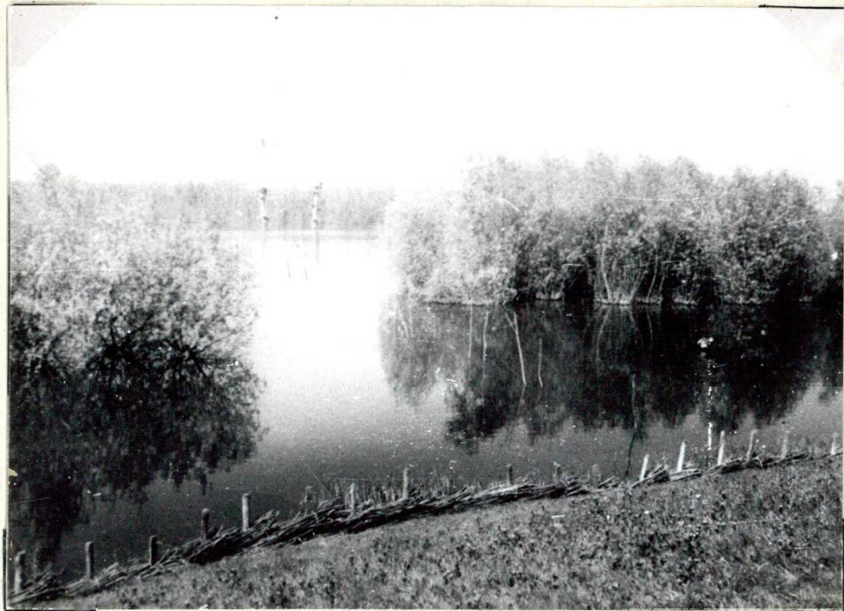
7. kép. A megáradt Tisza hullámaintól rózsével védik a gátat /1967/
