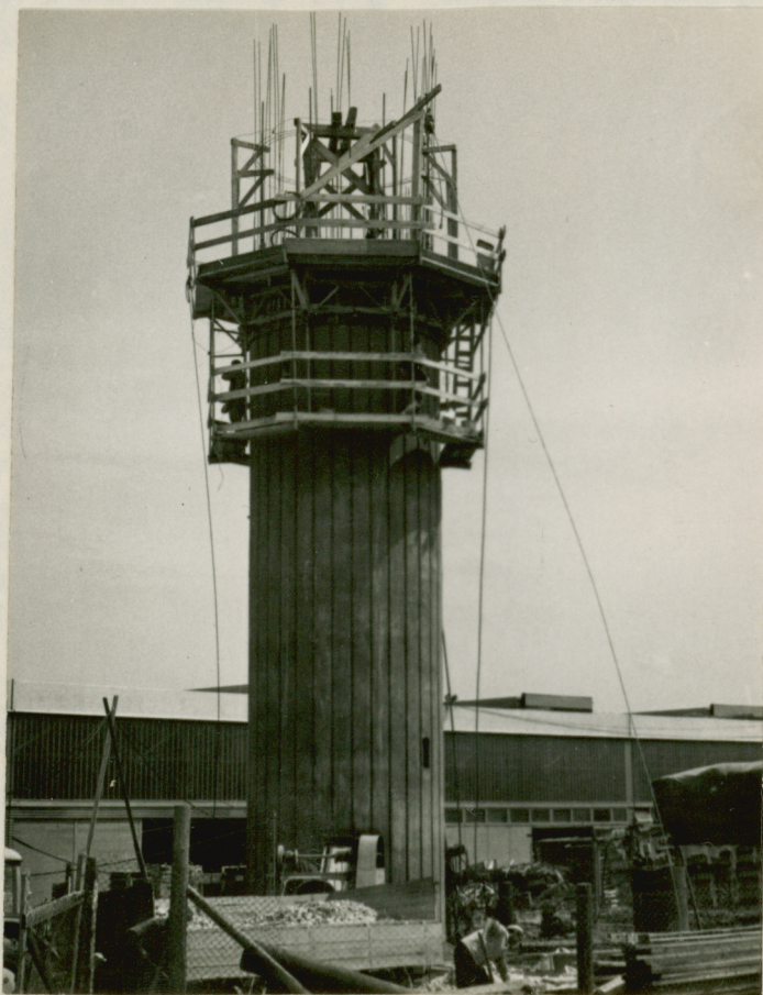
Az épülő víztorony
