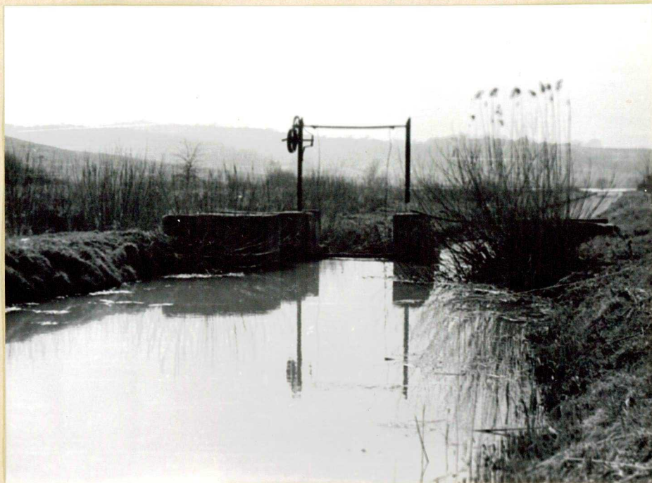
31.kép: Az Almás-patak vizét zsilipekkel duzzasztják fel a halastavak táplálására /Fotó: Lehmann A. 1961./
