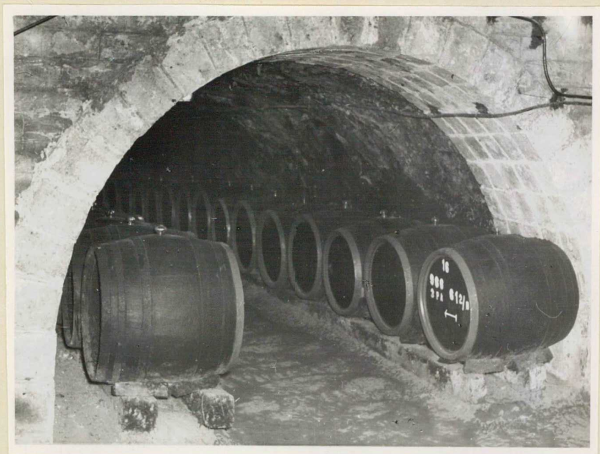
22. sz. kép: Előlt boltozott pinceág
