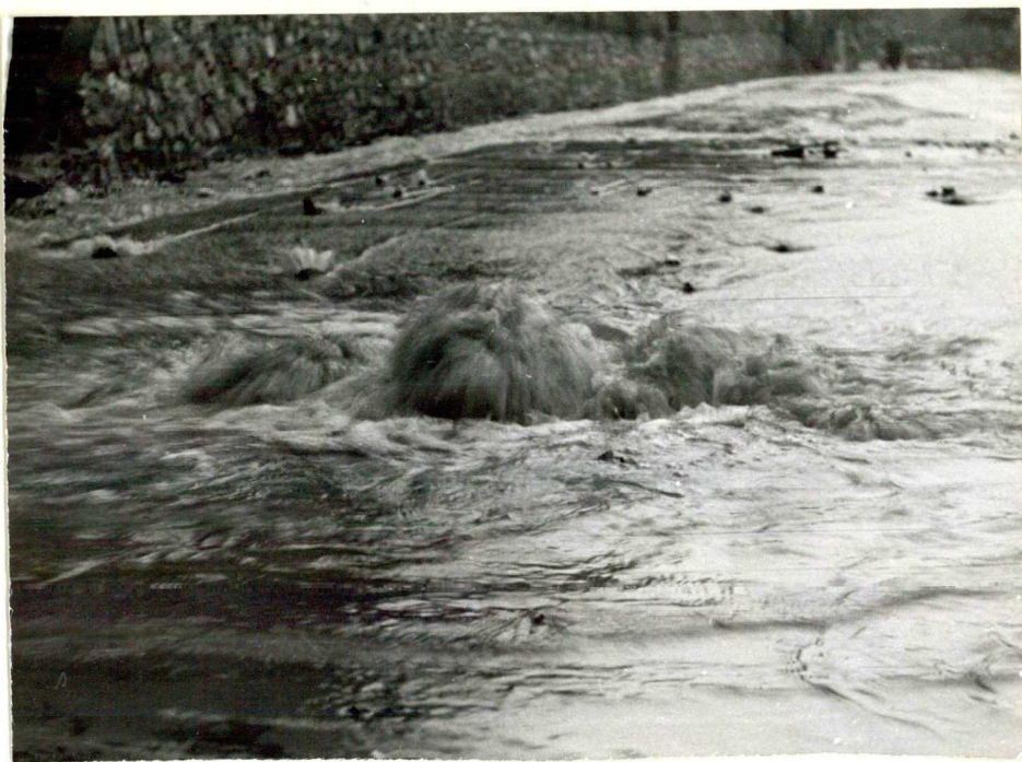
12.kép. Az István barlang alsó járataiban felgyülemelő víztö- meg nyomása a miskolc-egri műutat is felszakította.
