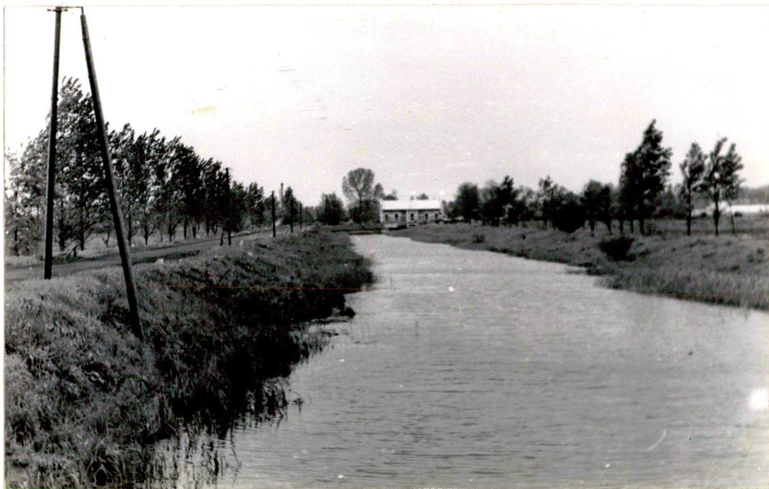
6.kép. Levezető főcsatorna a vízházzal.
