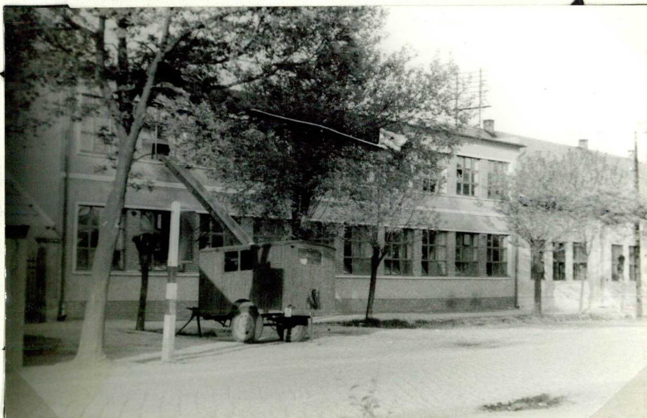
Békési Nyomda főépülete.
