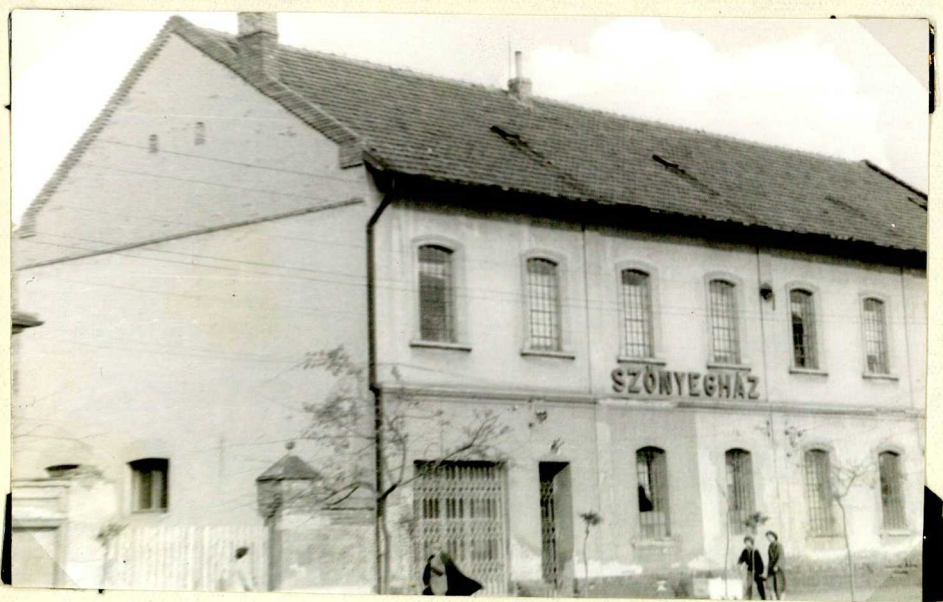
A Szőnyegház főépülete.
