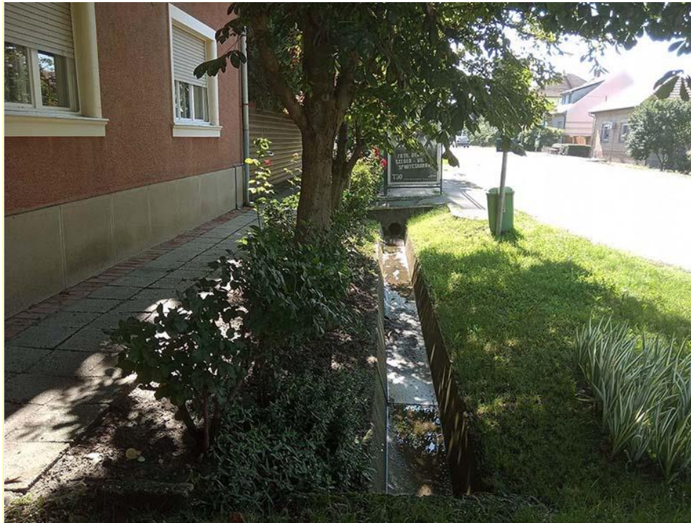
7. kép: A házfal mellett húzódó zöld alagút, Tápé, Árvácska utca keleti oldala. (fotó: Hornyák S. J. 2022)
