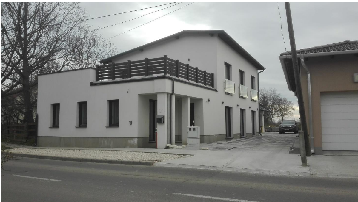
5. kép: Vízáteresztő és vízzáró kopár felületek egy új építésű kertvárosi ingatlan előtt Tápén. A baloldalon látható kavicsos terület vízáteresztő, a betonból készült autóbejáró vízzáró. (fotó: Hornyák S. J. 2022)
