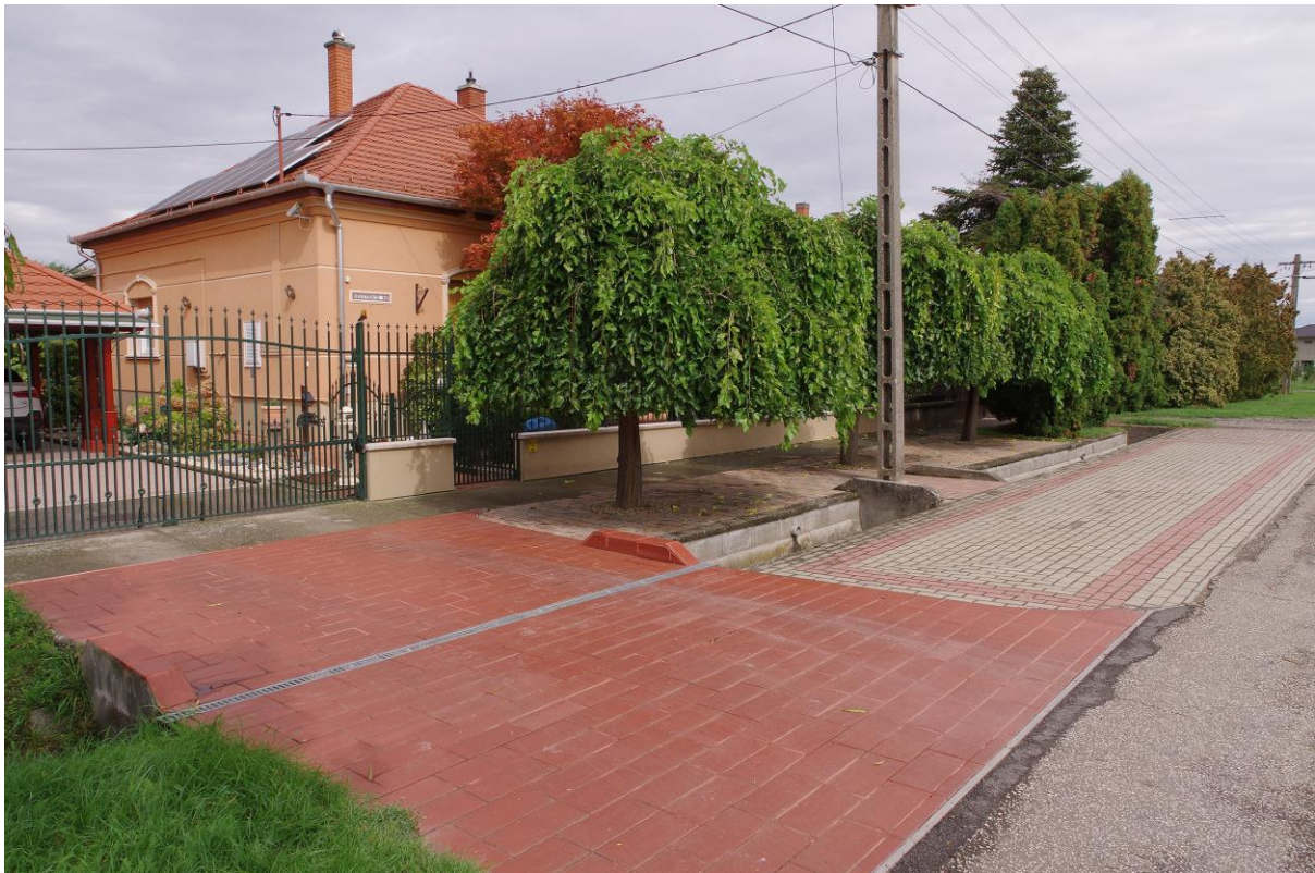
2. kép: A csapadékvizet csaknem teljes egészében elvezető burkolt felület Szeged-Tápén. (fotó: Hornyák S. J. 2022)
